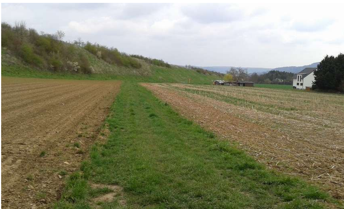
Abbildung 9 – Lärmschutzwall an der BAB A8, man erkennt die blühende Schlehe
